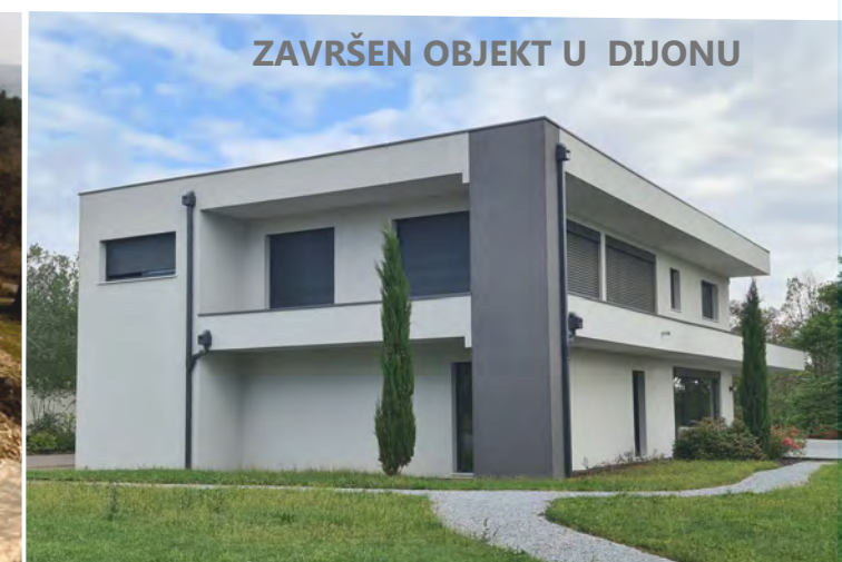
MONTAŽA DIJON FRANCUSKA
